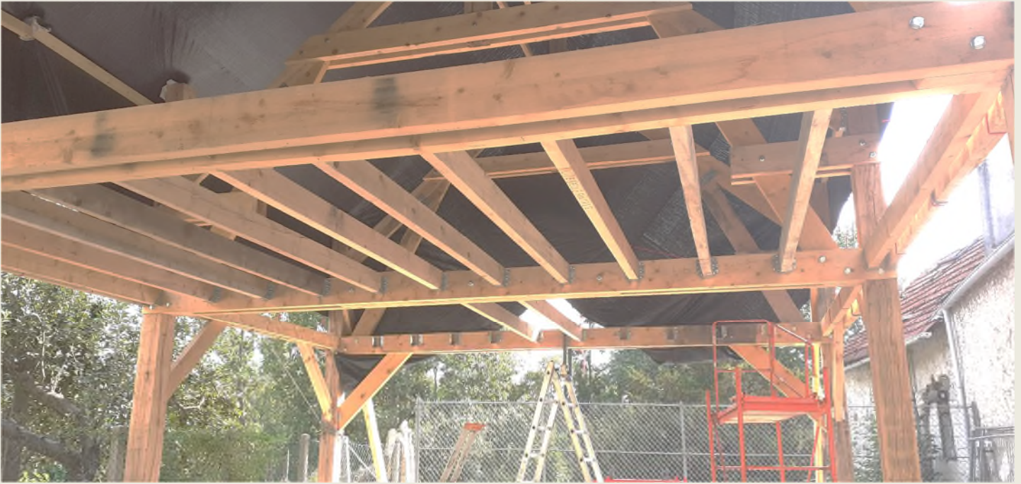
Structure du plancher pour le stockage
