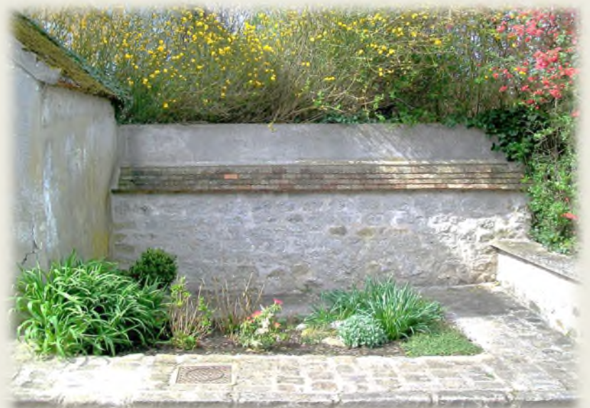
Ancien lavoir rue des Sablons
