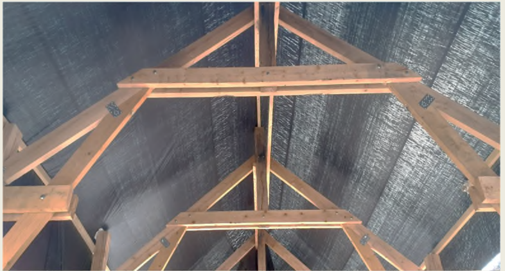
Charpente en place
